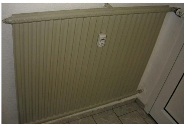
Nun ist theoretisch klar, wie heiß das Heizungswasser ist, aber dies trifft für einen Heizkörper mit Abmessungen 400 x 400 x 10 genauso zu, wie für einen mit 2000 x 600 x 150. Um dies ebenfalls zu berücksichtigen, brauchen wir noch die Heizleistung des betreffenden Heizkörpers.
